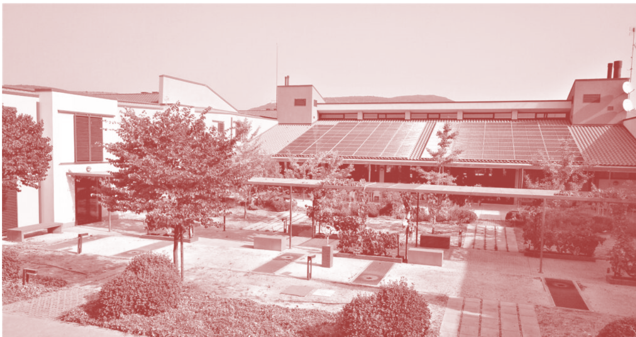
IMAGEN 1. TRABENSOL (PATIO INTERIOR). FUENTE: TRABENSOL 19 .
